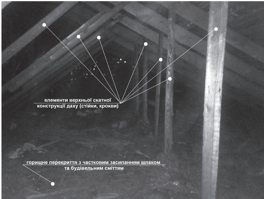
Рисунок 11. Горищний дах будівлі школи
